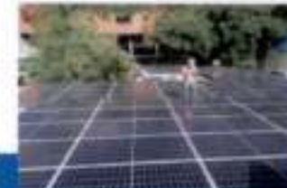
ENERGÍA QUISQUEYA Instalación paneles solares 32kWp
