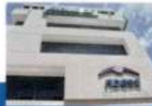
ADMINISTRADORA DE SUBSIDIOS SOCIALES (DATA CENTER) Instalación de potencia y suministro de plantas eléctrica (2 x 100kW) con sistema de insonorización.
