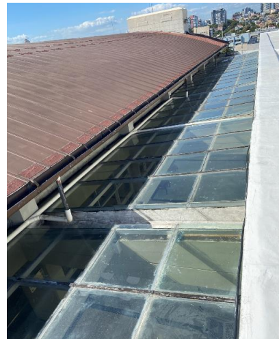
Techo Pasarela 7mo Piso
