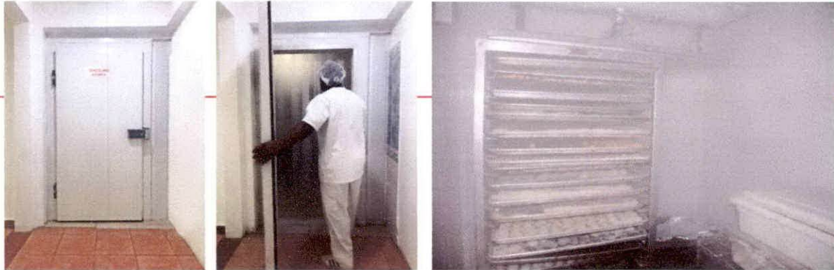
CUARTO FRÍO BOLLERÍA
