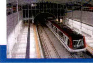
METRO DE SANTO DOMINGO Suministro de 3 generadores. De 2000kW. Total 64megavatios .
