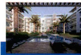
VIBE RESIDENCE, BAYAHIBE 2 elevadores de 1000 kgs
