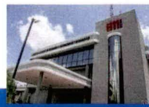
SISTEMA NACIONAL DE ATENCIÓN A EMERGENCIAS Y SEGURIDAD 9-1-1 2 generadores de 150kW c/u. Instalaciones eléctricas para ampliación Data Center Sto Dgo.
