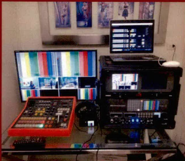
Switsher para Circuito Cerrado
