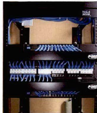
Ejemplo: Gabinete de Red Datos con espacio disponible para la instalación de los nuevos equipos.
